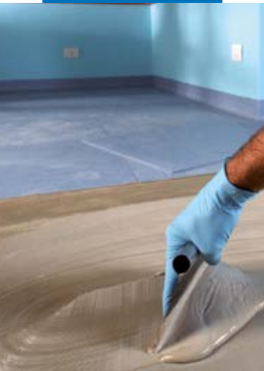
Aanbrengen van Ultrabond Eco 380
