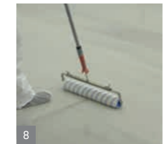
8 Aanbrengen van een toplaag
