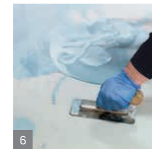
6 Aanbrengen van een gietvloer
