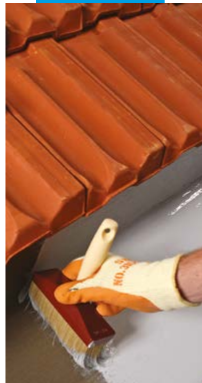
Voorbeeld van een dakgoot die waterdicht is gemaakt met Mapelastic Smart en afgewerkt met Elastocolor Waterproof
