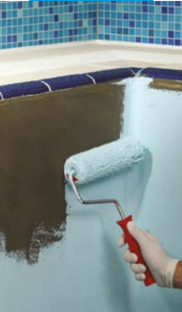
Aanbrengen van Elastocolor Waterproof met een roller
